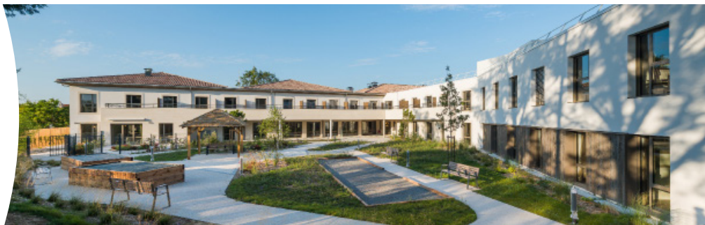
Villa de Valerose - Latresne (33)
